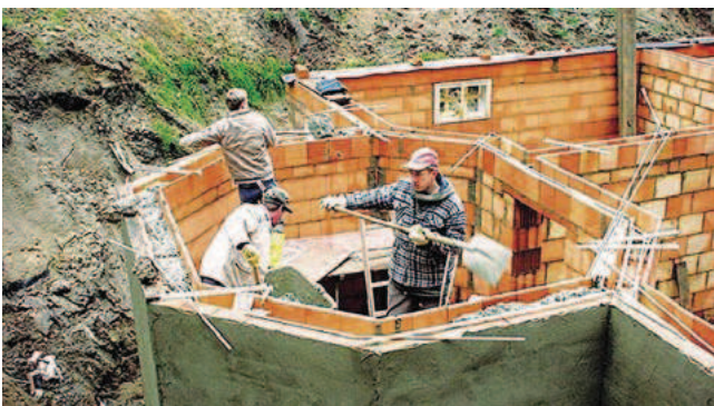
Zbrojenie ścian domu jednorodzinnego w Bad Lippspringe, Niemcy, [M6]
