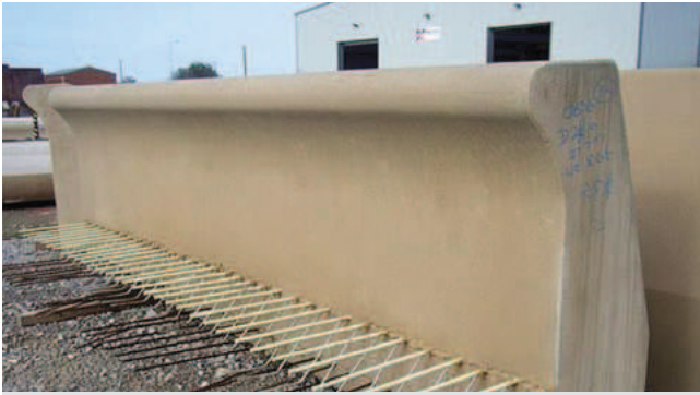
Umocnienia brzegowe wzdłuż promenady nadbrzeżnej w Blackpool, Wielka Brytania, zbrojone prętami GFRP [M5]
