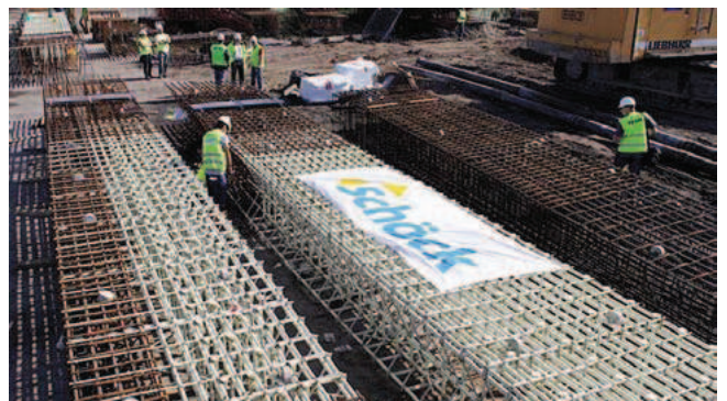
Zbrojenie ścian tunelu pod Martwą Wisłą w Gdańsku, Polska [M5]
