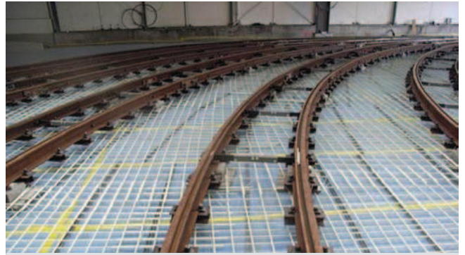
Zbrojenie płyty fundamentowej trasy kolejowej w Bazylej, Szwajcaria [M6]
