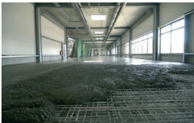
Rys. 4. Zbrojenie posadzki prętami GFRP [źródło: Schöck Sp. z o.o.]
