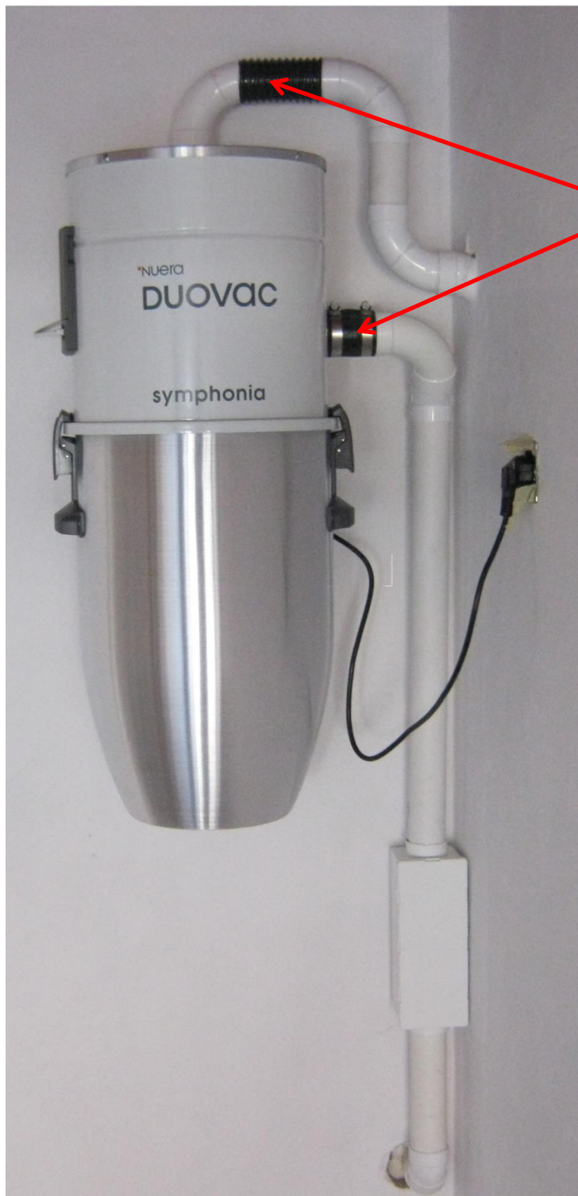
Rys. 5. Jednostka centralna z tłumikiem zamontowanym w dół
