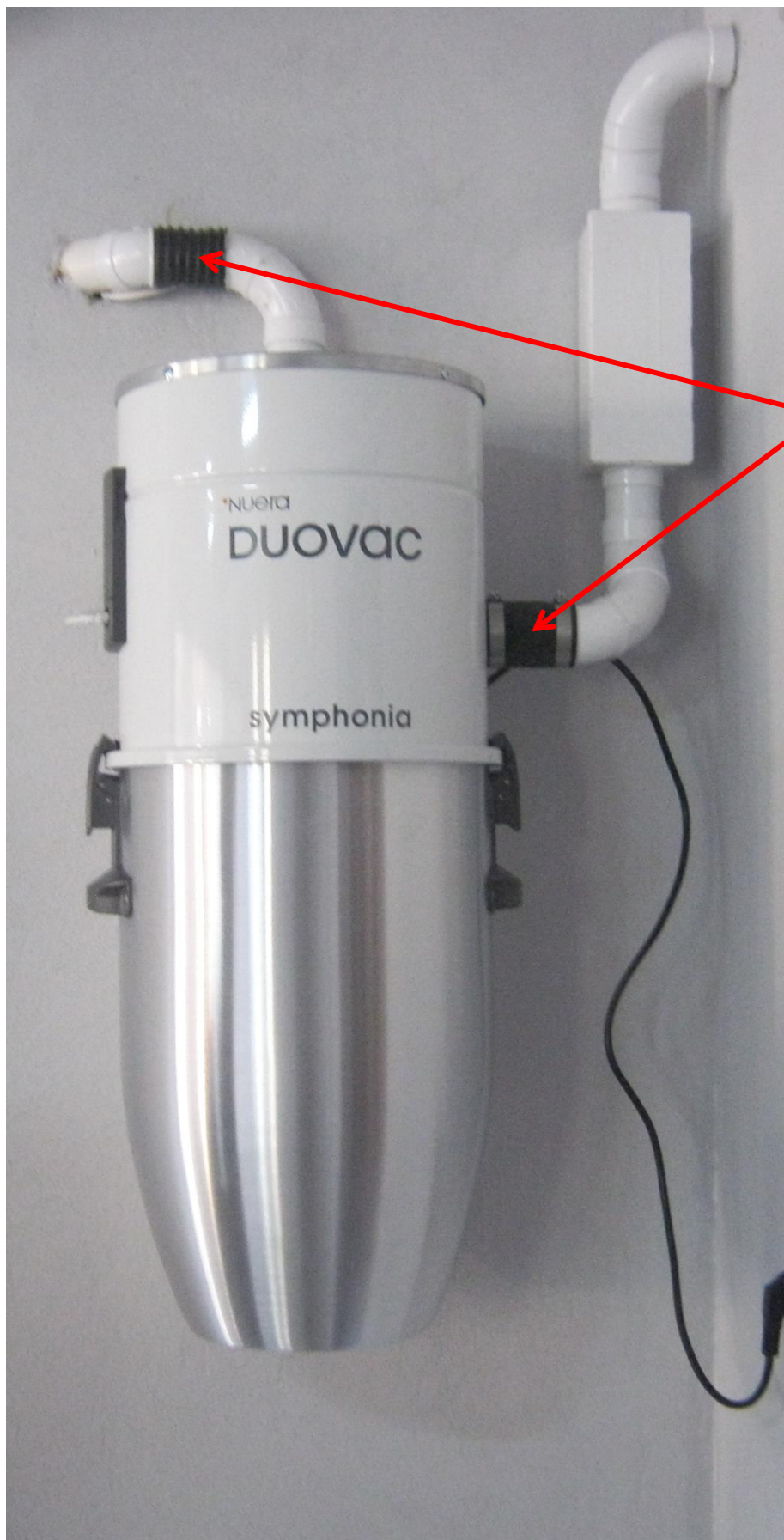
Rys. 6. Jednostka centralna z tłumikiem zamontowanym w górę
