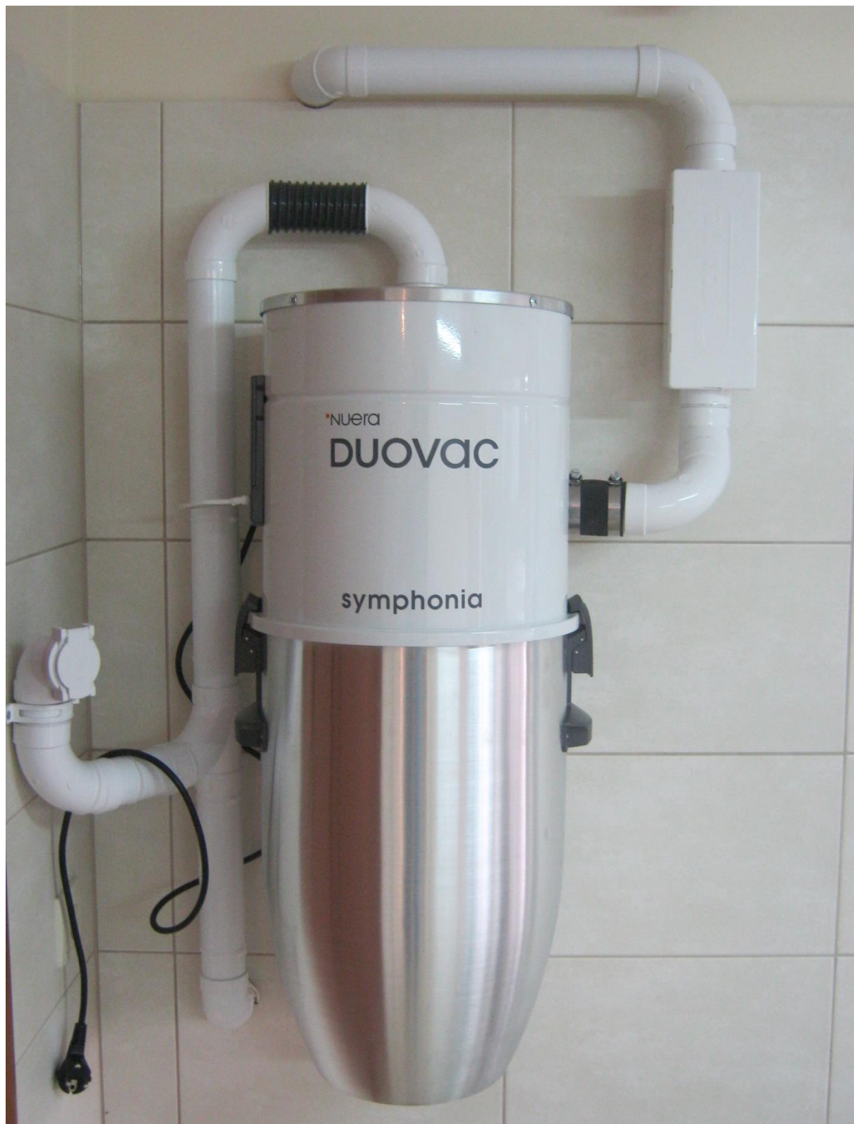
Rys. 8. Jednostka centralna z zamontowanym gniazdem natynkowym
